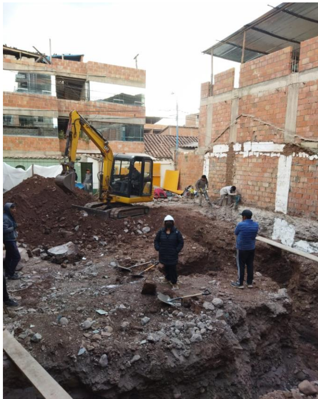
Foto 14: Eliminación de escombros a través de un servicio de vehículo particular que se encarga del carguío, transporte y disposición final.
