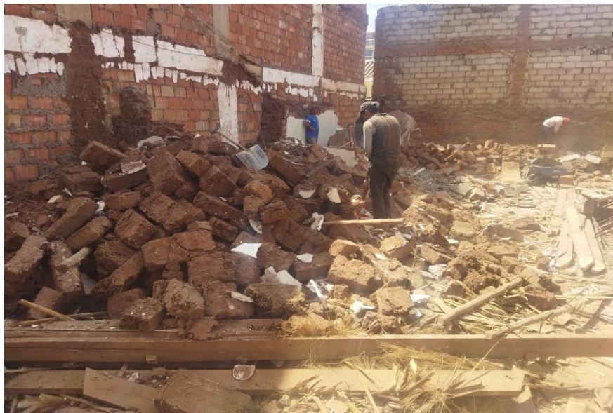
Foto 8: Escombros producto de las demoliciones de la edificación existente.
