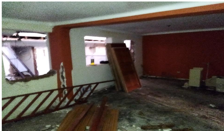
Foto 4: Retiro de pisos, instalaciones de agua y electricidad
