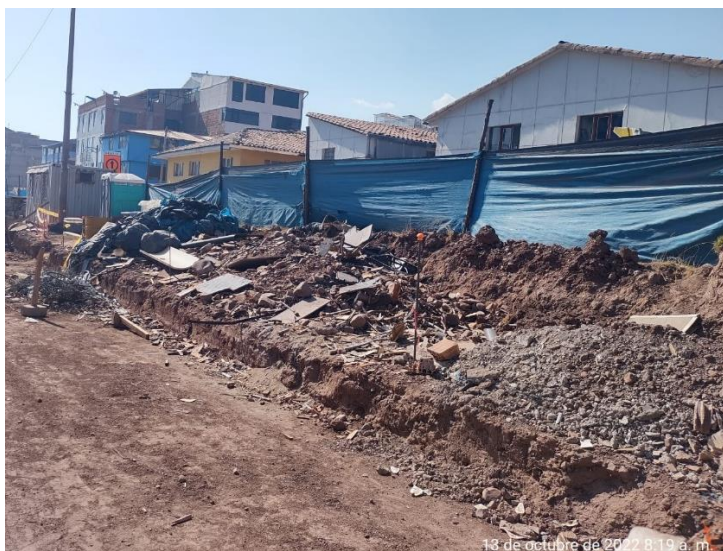
Foto 20. Acopio temporal de RCD dentro de obra.
