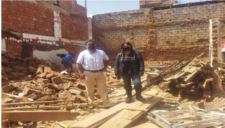
Foto 7: Supervisión de la Inspectora de la MPC.
