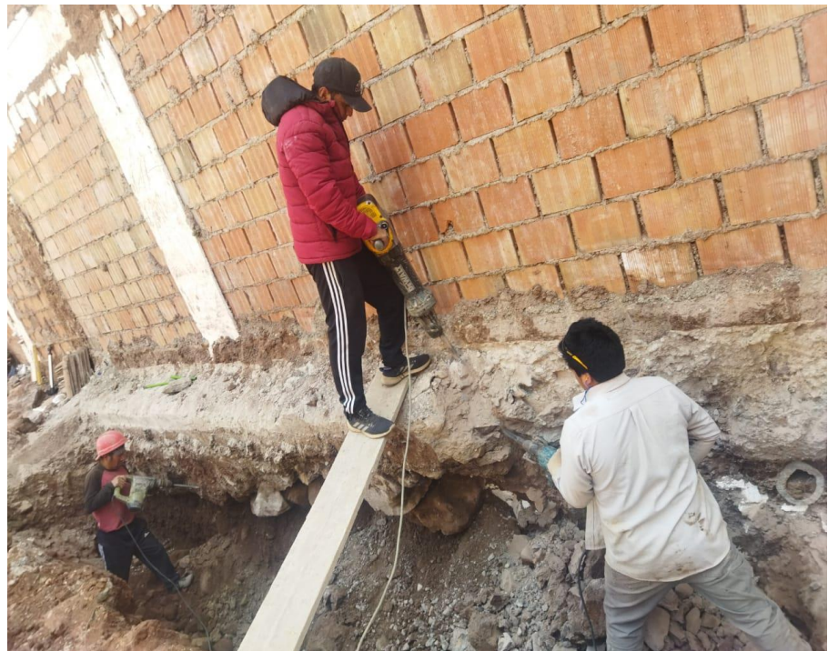
Foto 11: Rotura de bloques de concreto con la utilización de equipo de perforación y maquinaria liviana.
