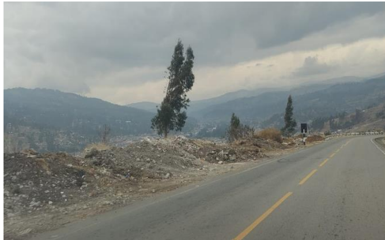
Foto 16: Eliminación de RCD – Ruta Cusco – Pisac.
