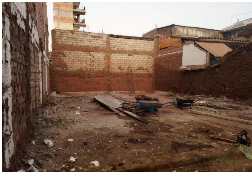
Foto 9: Resultado de la demolición de edificación a nivel de piso, una vez demolida la edificación y eliminado los escombros.
