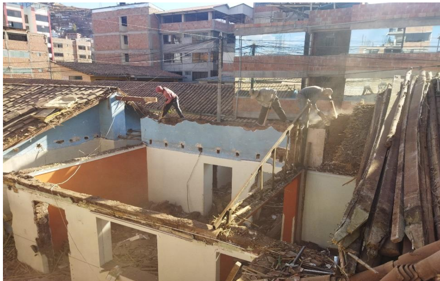
Foto 5: Proceso de demolición de muros de adobe.
