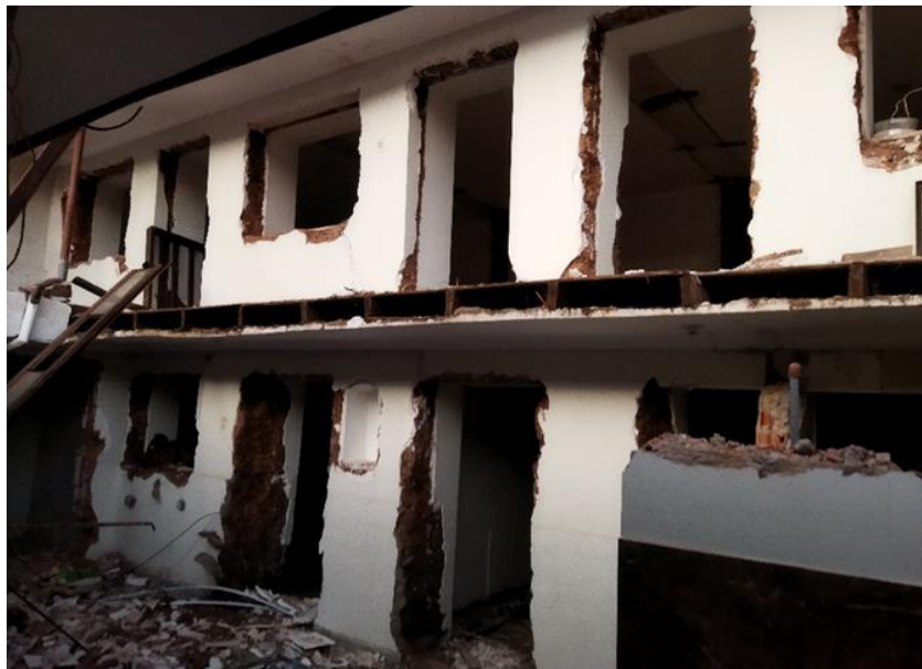
Foto 3: Desmontaje de la edificación.
