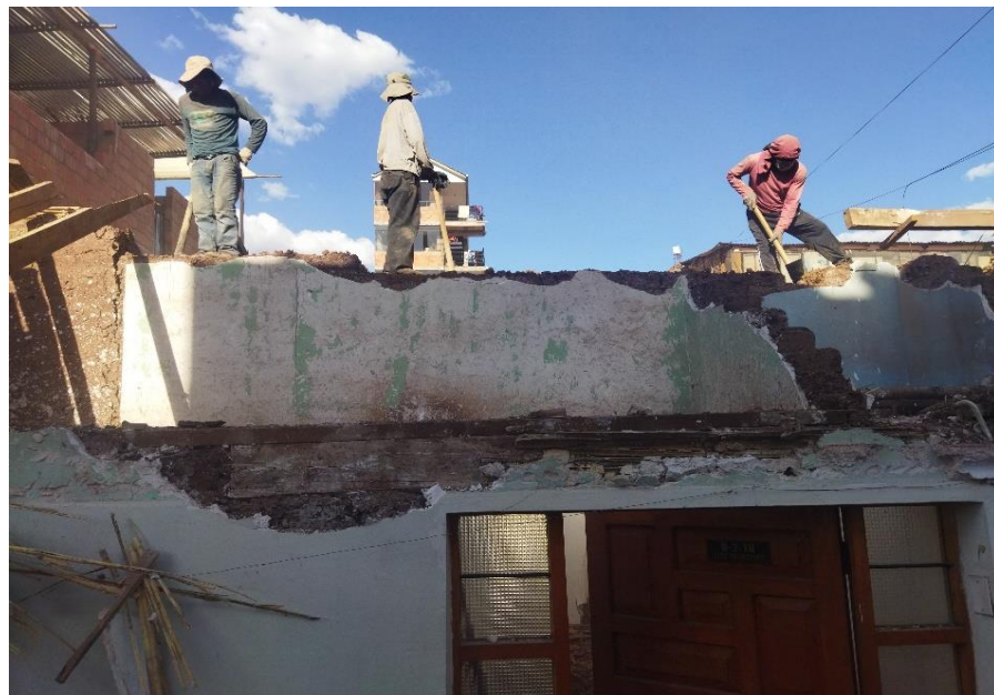
Foto 6: Demolición de muros y retiro de instalaciones de electricidad
