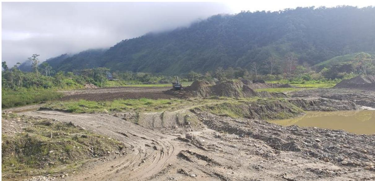
Nota: En la figura se indica zonas de reconformación y nivelación de terrenos intervenidos o que han sido ya explotados dentro de la concesión minera Linder.
