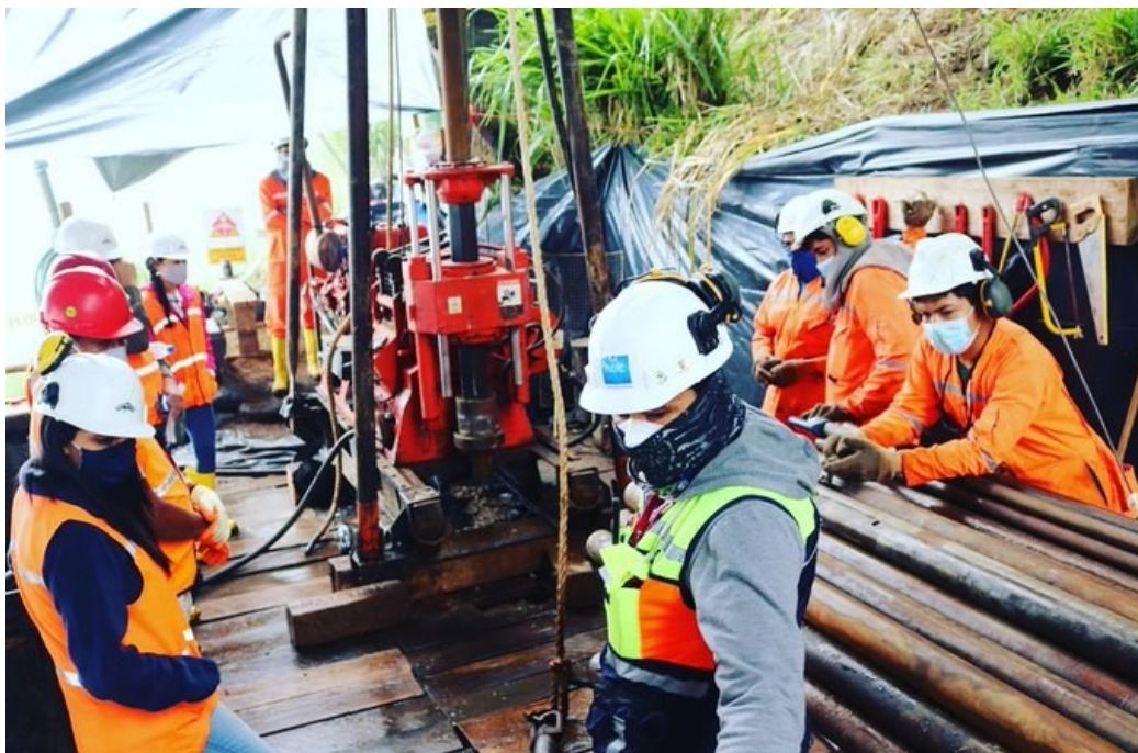
Figura 5. Proceso de perforación
