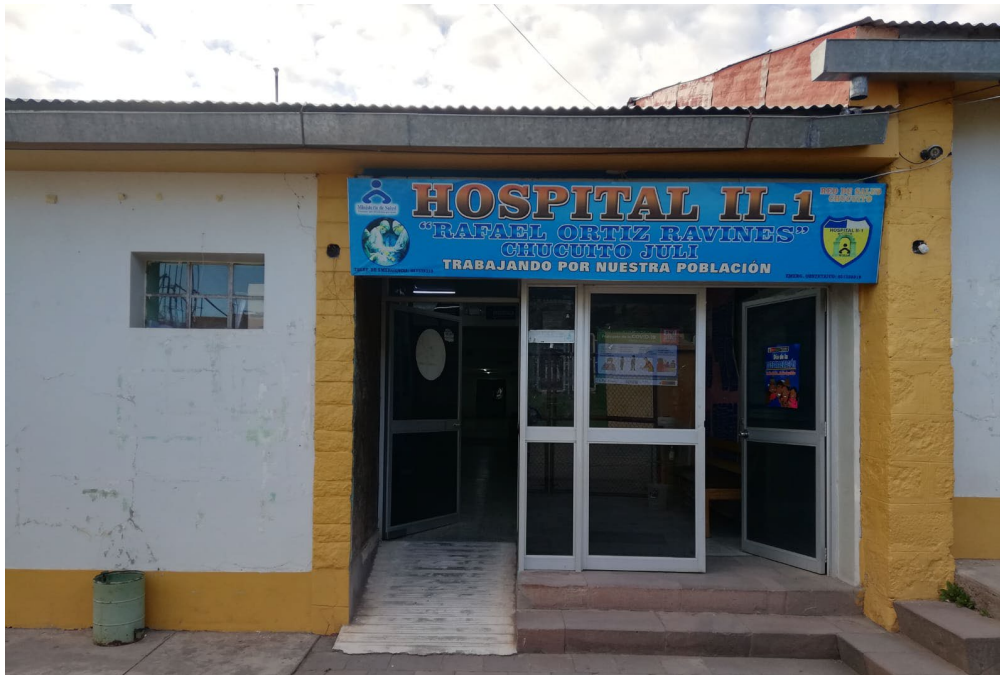
Figura 6: Puerta de ingreso al Hospital "R.O.R." Juli Fuente: Fotografía tomada por los autores
