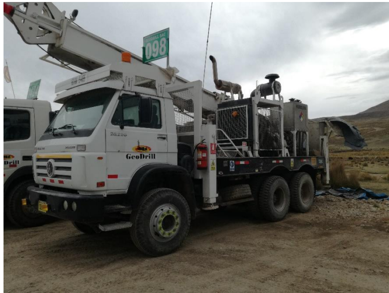
Figura 4 Máquina Perforadora Geo 3000
