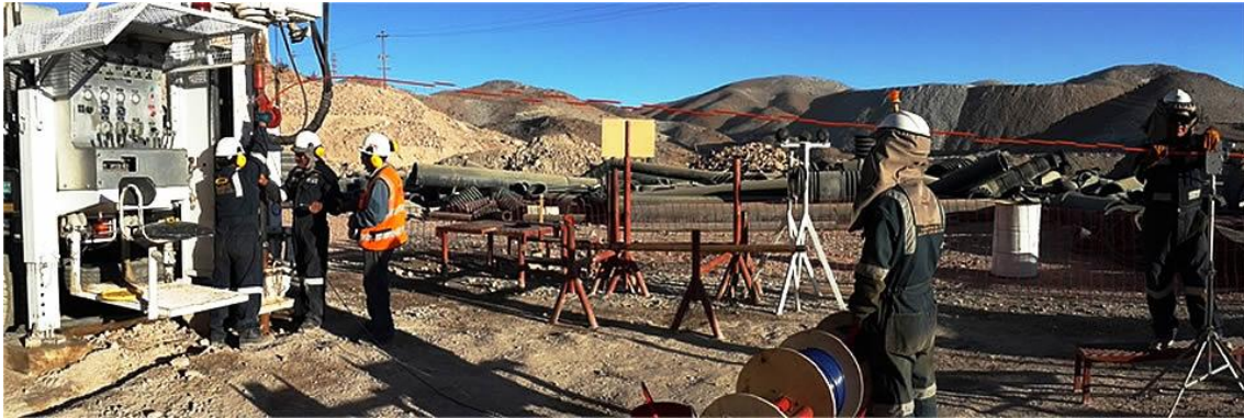
Figura 6 Instalación de Piezómetros
