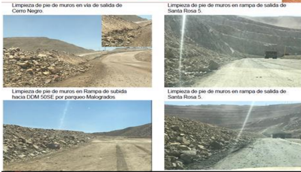
Figura 27. Limpieza de pie de muro Fuente Cerro Verde
