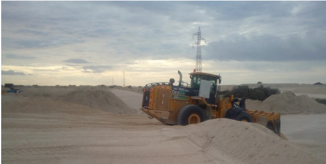
Figura 10 Posiciones correctas para uso de equipos pesados
