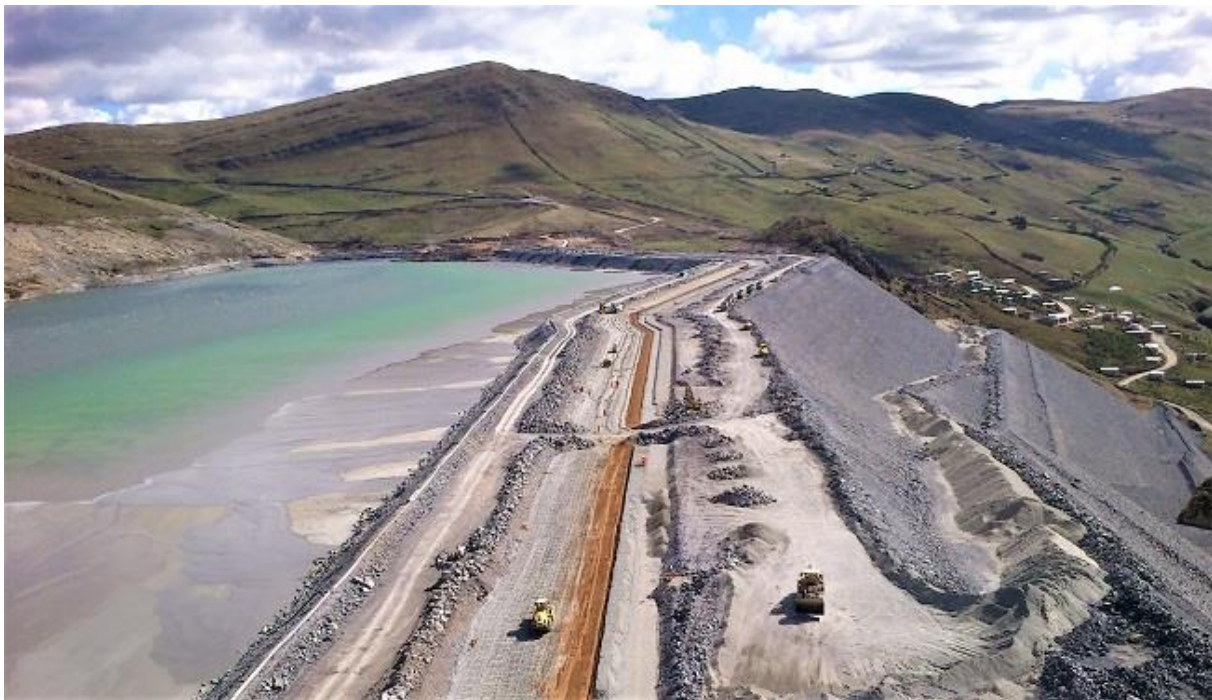
Figura 6. Presa de relaves
